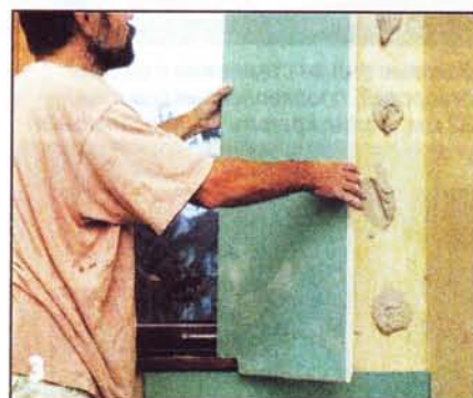
В некоторых местах, например, где стены обшиваются кусками плит, клей наносят на стену.
