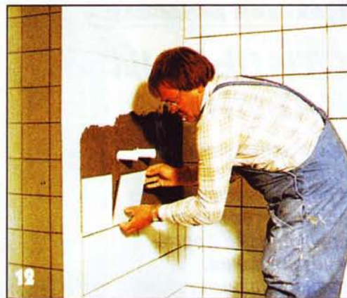
12 Стены душевой и зону над умывальником облицевали керамической плиткой.
