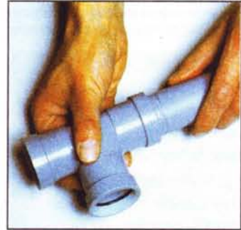
Соединение способом «плотный стык». Вставляют трубу в фитинг до упора и делают на ней отметку по торцу фитинга, а затем, чтобы обеспечить зазор на температурное расширение, вытягивают трубу на 10 мм.
