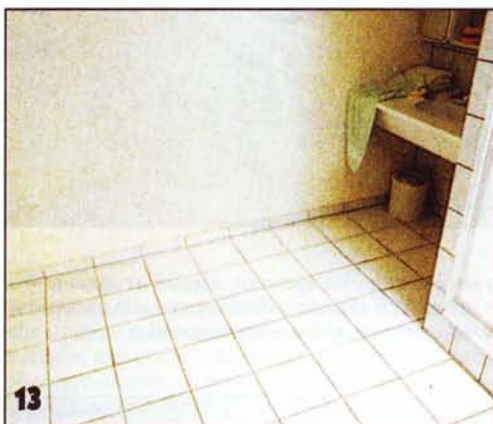
13 Отделка помещения завершена вплоть до последнего уголка.
