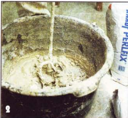
Неровные стены обшивают гипсокартонными плитами на клею. Клей замешивают настолько густым, что его можно спокойно, не опасаясь сползания, наносить «лепёшками» на тыльную сторону плит.
