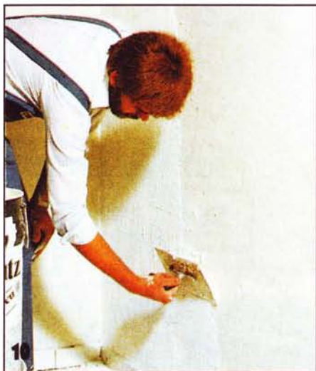
10 На подготовленные стены нанесли водо- и паропроницаемую штукатурку.
