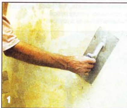
Места, где при удалении старых обоев была повреждена основа, заделывают шпатлёвкой.
