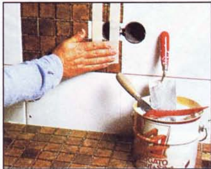
Плитку кладут так, чтобы правая и левая стороны были симметричными.
