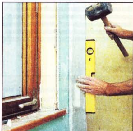
Вертикальность плит проверяют по уровню и, если надо, подправляют с помощью алюминиевой рейки и резинового молотка.
