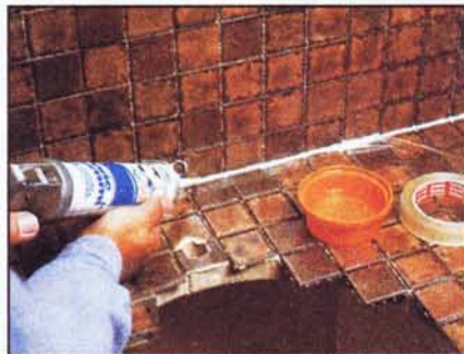
Пристенный шов заполняют эластичным герметиком.
