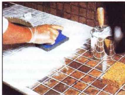
Швы между плитками заполняют эпоксидной затиркой.
