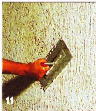
11 В зависимости от размеров зёрен штукатурки оштукатуренная поверхность может выглядеть по-разному.
